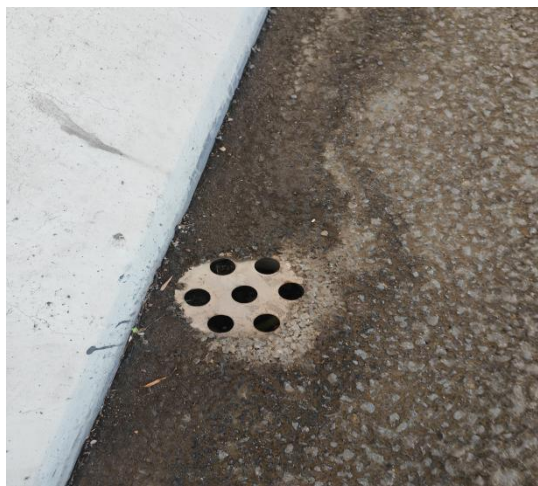
高架路排水孔
